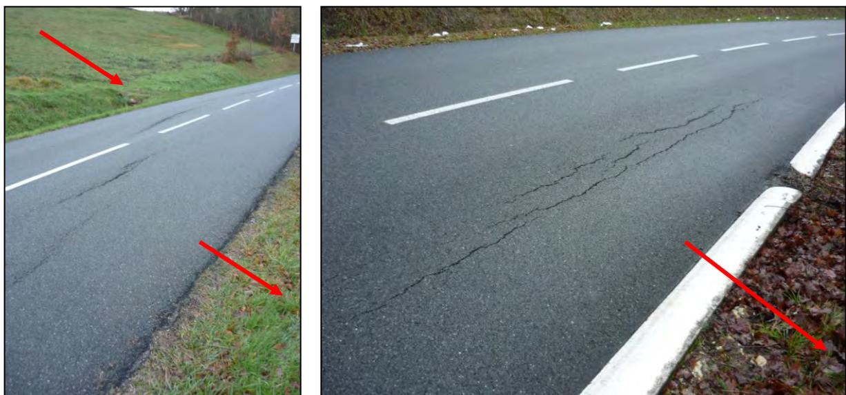
**Figure 20 :** Fissuration de la RD 7 entre Bel-Air et Brassac [Source : IMS<sub>RN</sub>]
